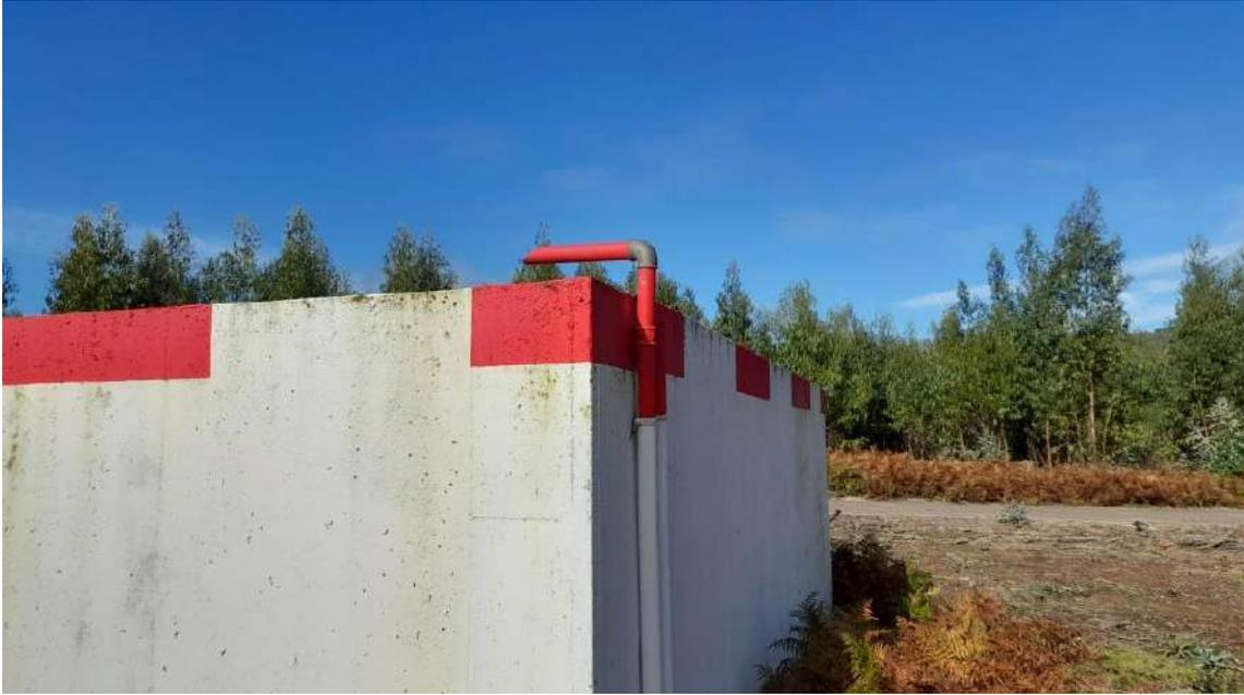
Aspecto do tanque para a protecção civil, com o tubo para enchimento proveniente da nossa bomba na ribeira.
