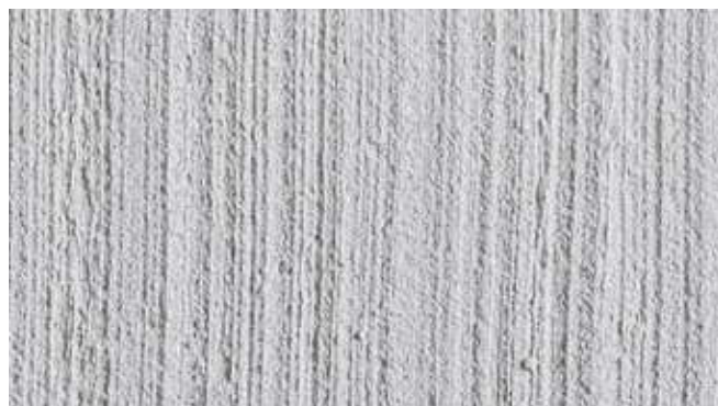
AUS Modellierputz (superfície modificada com escova)
