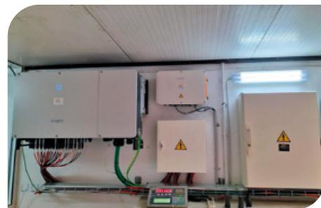
fundamental para a gestão otimizada centralizada da geração de energia solar. Para atender a esse requisito, foi instalado o dispositivo de comunicação COM100 e um wattímetro DTS-DI352-C, permitindo a monitorização e supervisão dos parâmetros de operação dos inversores.
