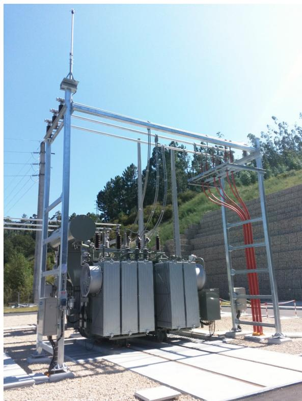
Fixação de Transformadores de Potência com rodas em carris sobrelevados.
