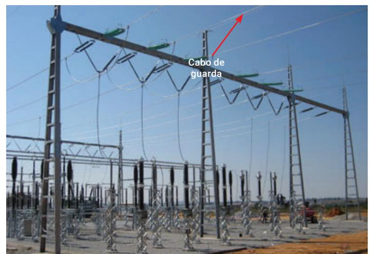
Figura 1. Cabos de guarda.
