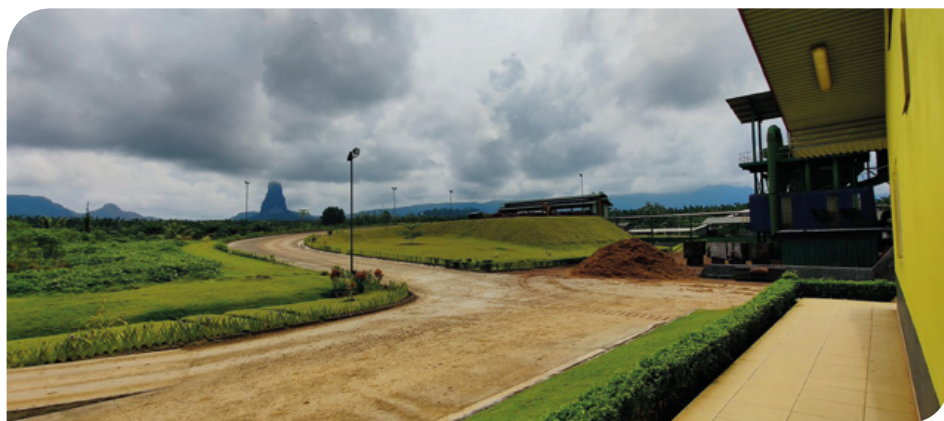
Figura 5 Local da futura instalação da central de cogeração SCIVEN alimentada a biomassa residual para a produção de calor (fornecido a uma unidade industrial) e eletricidade para 3 comunidades de São Tomé e Príncipe, actualmente sem acesso à rede eléctrica nacional em São Tomé e Príncipe.
