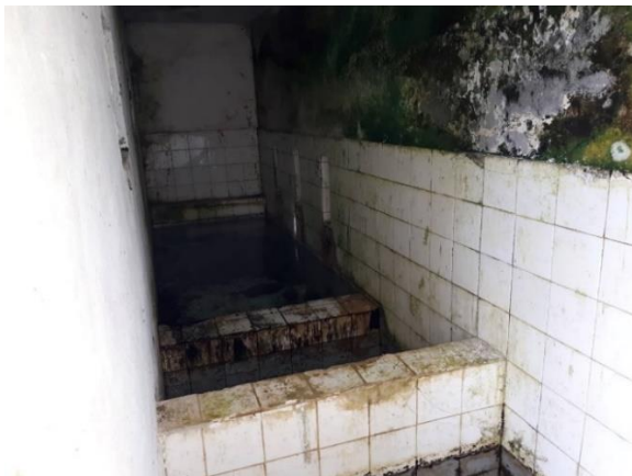
Foto 11 – Interior da câmara de captação das fotos anteriores
