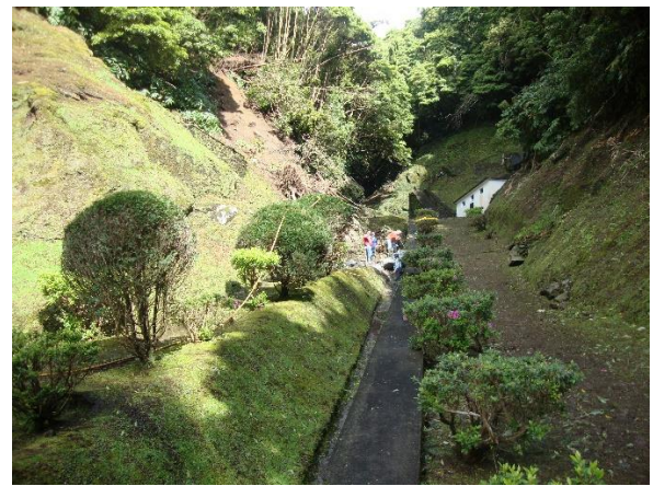
Foto 16 – Obras de conservação num conjunto de captações
