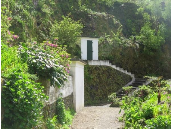
Foto 13 – Zona de protecção imediata com manutenção
