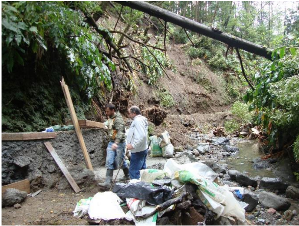
Foto 15 – Obra de conservação numa nascente de difícil acesso
