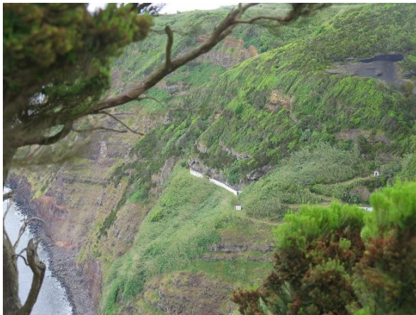
Foto 5 – Captação de água numa encosta
