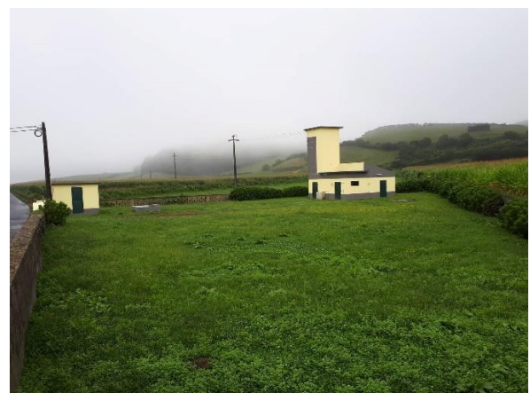
Foto 4 – Furo de captação de água numa zona rural
