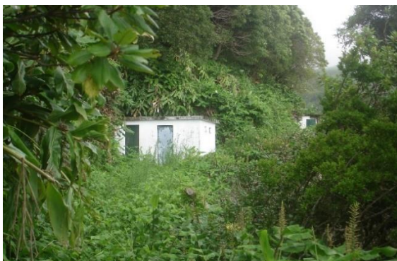
Fotos 7 e 8 – Zonas de protecção imediata sem manutenção
