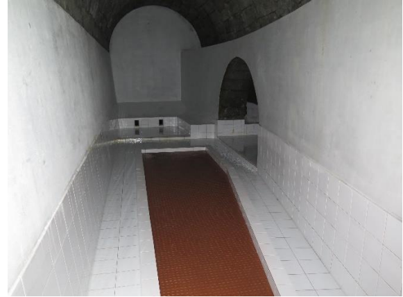
Foto 14 – Interior de uma câmara de captação sem zona de protecção tratada
