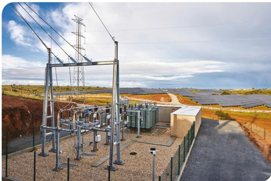
**Figura 3** O ponto de entrega de energia na rede pública é uma nova subestação, onde há também um elevador da tensão de 30 kV (recebida dos postos de transformação) em 60 kV.
