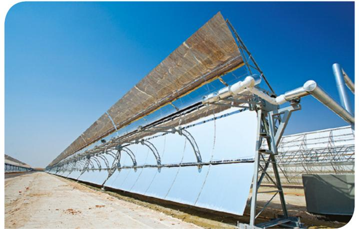
**Figura 6** Instalação para a produção de eletricidade solar térmica com coletores cilíndrico-parabólicos (Masdar Official, CC BY-SA 2.0 <<https://creativecommons.org/licenses/by-sa/2.0/>>, via Wikimedia Commons).
