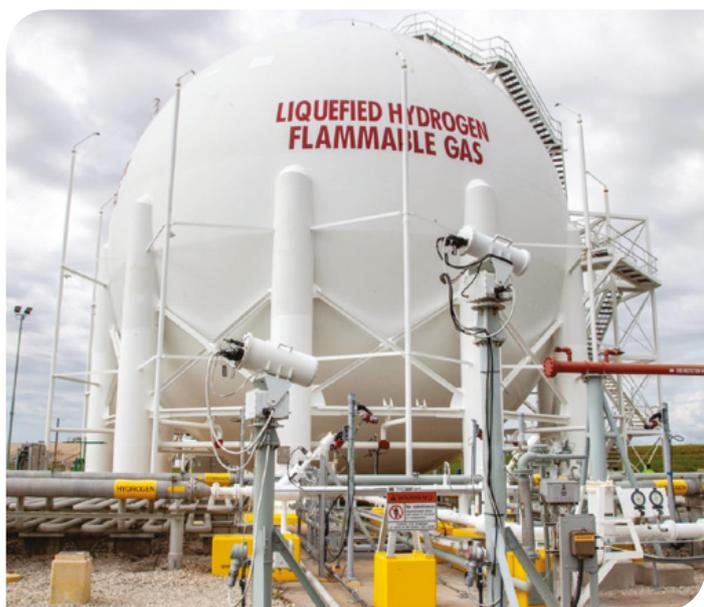
**Figura 7** Armazenamento de hidrogénio liquefeito (DOE, Public domain, via Wikimedia Commons).
