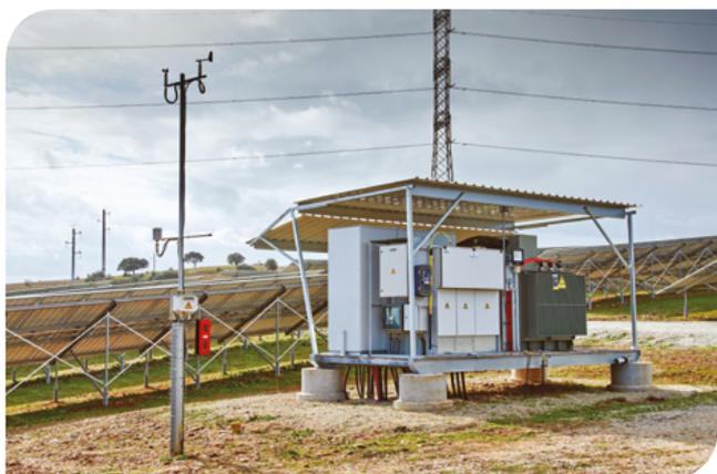
**Figura 2** As tensões DC são convertidas de 0,4 kV para 30 kV em 20 postos de transformação.
