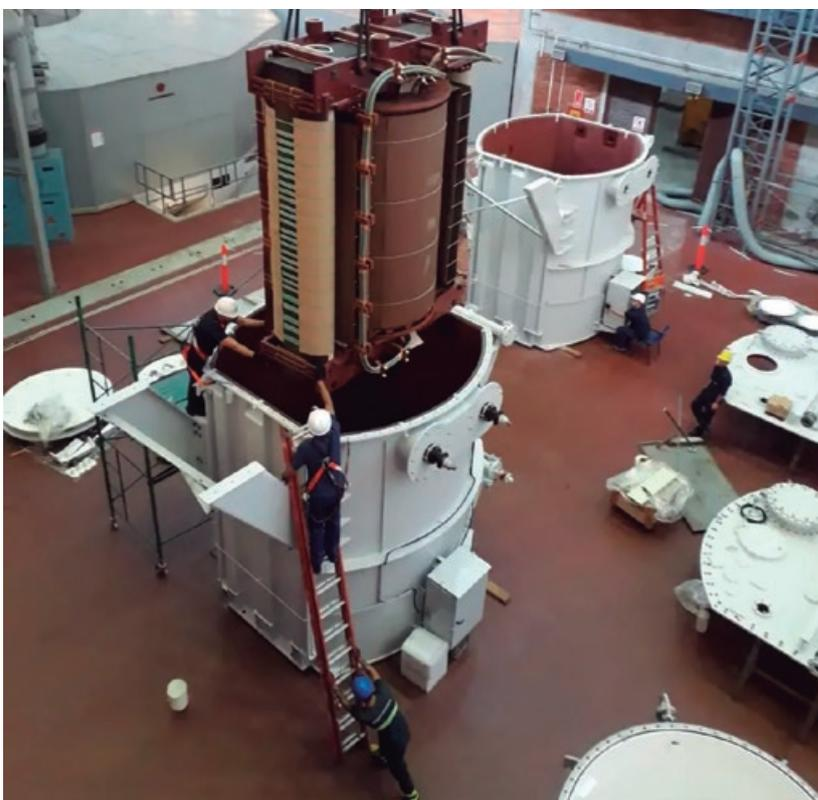
Este trabalho foi efetuado pela equipa da Assistência Técnica em articulação com a equipa de engenharia da WEG, e visou a reparação de 6 transformadores de 37 MVA – 550 kV fabricados originalmente em 1980, num projeto elaborado pelo governo do Uruguai que tem como base a renovação do sistema elétrico deste país.
