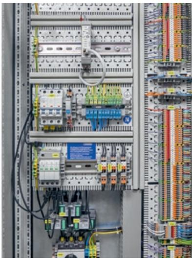
**Figura 3.** O módulo ImpulseCheck é a peça central do sistema: recolhe os sinais dos sensores e do contacto auxiliar do DST e transmite as medições à Proficloud.
