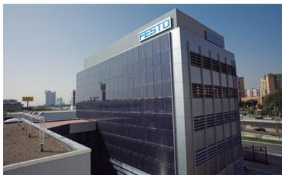
A Festo prevê reduzir o seu custo energético em 27% graças à utilização de 300 painéis fotovoltaicos instalados na fachada da sua sede, em Barcelona. Este sistema permite, ainda, gerar menos emissões de dióxido de carbono e o início do seu funcionamento em 2008 permite fazer uma estimativa com resultados consolidados anteriormente.
