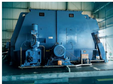
A WEG realizou, para a unidade da REPSOL em Sines, o fornecimento de 1 motor síncrono Exp, 7,2 MW, 6 kV, 30 polos, mais o quadro de excitação, desenvolvendo e implementando uma solução de automatismos de interligação e proteção.
