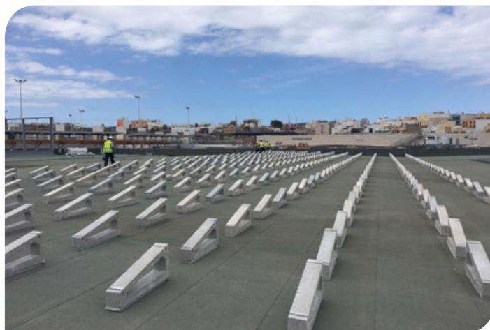
O SOLARBLOC® serve como estrutura de betão para a montagem de painéis fotovoltaicos, tanto em parques solares como em telhados e superfícies planas. Através deste produto, a Pretensados Durán S.L. mostra e reforça o seu compromisso com a inovação, qualidade e respeito pelo meio ambiente.
