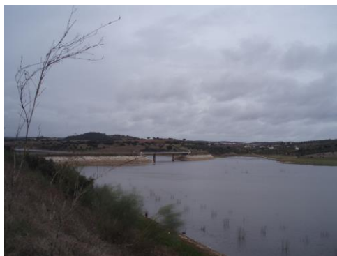
Fotografia 8.14 | Ponte sobre o Lucefécit
