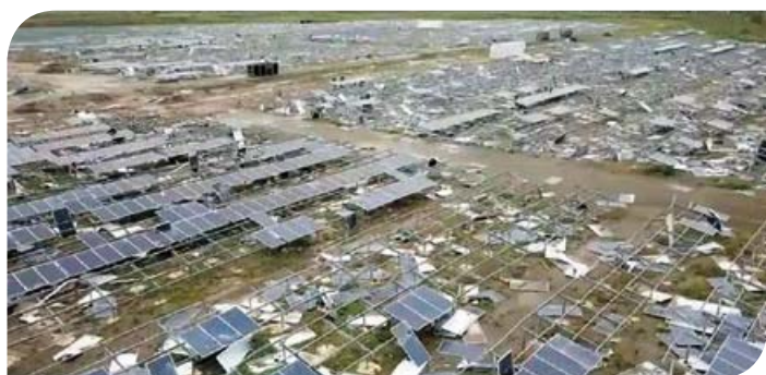
Figura 1 Um parque fotovoltaico em ruína onde elementos químicos potencialmente tóxicos dos painéis migrarão para o solo.
