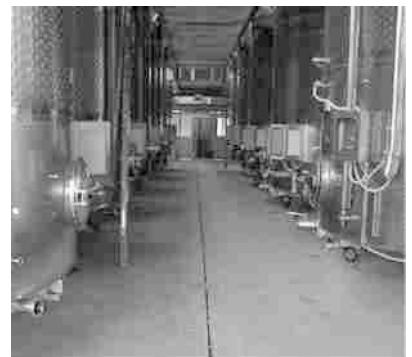
Canal com ranhura central de 20mm, que não necessita de grelha de cobertura e que, após a sua instalação, só se observa a ranhura central e os bordos da caleira.
