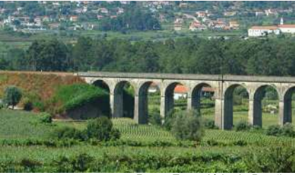
Ponte Ferroviária de Durrães
