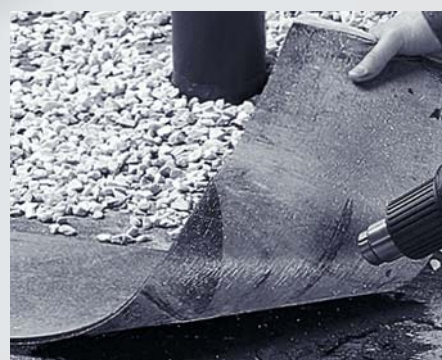
Termossoldagem de tela asfáltica
