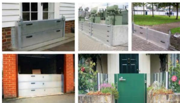
Figura 16 | Exemplos de barreiras desmontáveis contra inundações (fonte: *EHLG/IG, 2009*)
