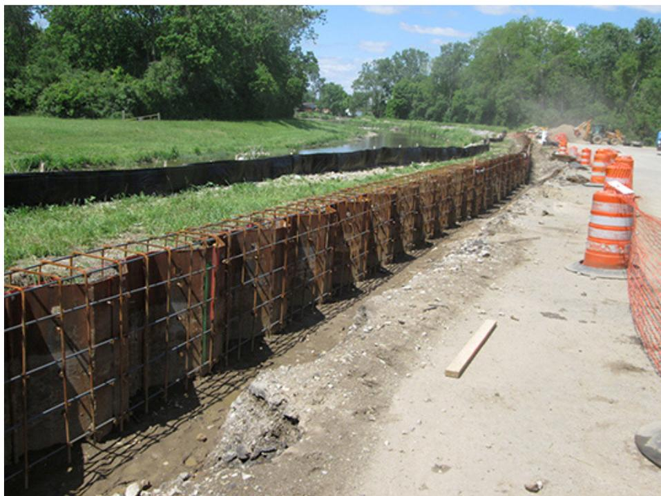
Figura 4 | Construção de muros como parte de estratégia de defesa de inundações (fonte: *EHLG/IG, 2009*)
