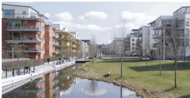
Figura 10 | Exemplo de bacia de retenção como parte de um sistema de gestão de inundações (fonte: *EHLG/IG, 2009*)
