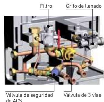
**Detalle de los componentes del kit hidráulico**
