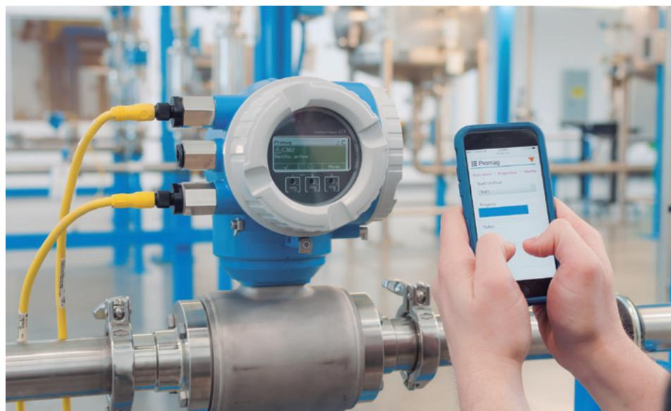
Figura 4. Para verificação de campo, um técnico liga um dispositivo ao servidor *web* através de uma conexão WLAN opcional. O mesmo procedimento pode ser realizado via PC com ligação Ethernet. O equipamento não precisa de ser removido para este procedimento.
