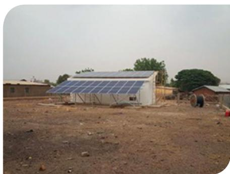
**Figura 2** Módulos solares na cobertura e no solo, atuando como tela de sombreamento.
