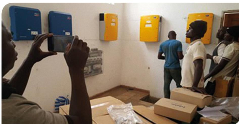
**Figura 3** Distribuição em edifício dos inversores SMA STP e SI e painel de proteção geral.
