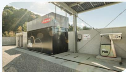
A Fronius implementou a primeira instalação de clientes H2 na Áustria, o Fronius Solhub, uma solução de sistema para geração local, armazenamento e uso de hidrogénio verde. O cliente é o SAN Group, que produzirá até 100 kg
