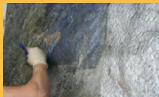
Toda a superfície de FLEXI-SLATE deve ser tratada com um pincel de 5 a 10 cm de largura. Aplique em condições climáticas adequadas - faixa de temperatura de +10 a +25 ° C, sem precipitação durante pelo menos 12 horas após a aplicação.
