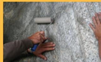
Usando o rolo de pressão, pressione a placa. É necessário desenvolver força adequada para espalhar o adesivo uniformemente.
