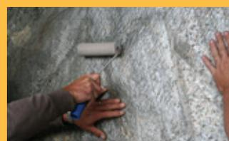
Usando o rolo de pressão, uniformize a colagem de FLEXI-SLATE. É necessário desenvolver força adequada para espalhar o adesivo uniformemente.
