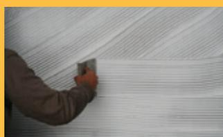
A instalação de FLEXI-SLATE deve ser feita sem juntas entre placas individuais. No caso de uma junta, a junta deve ser tratada com uma argamassa de silicone para exterior.
