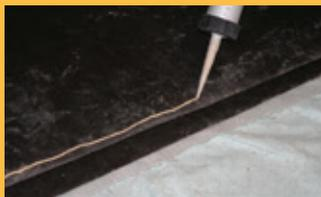
Aplice o adesivo MEGA FIX de forma uniforme em todas a superfície da placa a uma distância de 10-20mm da borda.
