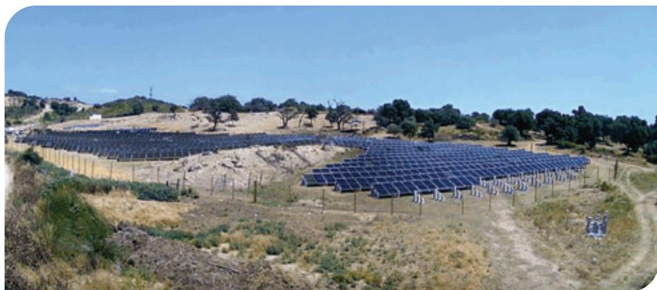
A Solventa6 está atualmente a avançar na fase de instalação das estruturas metálicas e dos painéis solares, que já começam a cobrir o local com uma orientação ideal para maximizar a produção. A vedação perimetral está também a ser construída para garantir a segurança da instalação.
