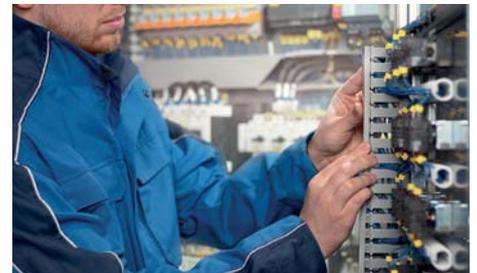
As calhas com rasgos Heladuct disponíveis com rasgos estreitos ou largos. Em ambas as calhas é possível retirar as linguetas de forma fácil e segura até à sua base ou até à base da calha para derivações. Arestas suaves para evitar danos nos cabos ou no utilizador.
