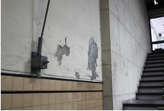
Fotografia 5 – Interior do Terminal Rodoviário
