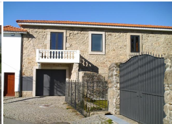
Fig. 6.2 – Casa Rural em Sermonde - Atualmente
