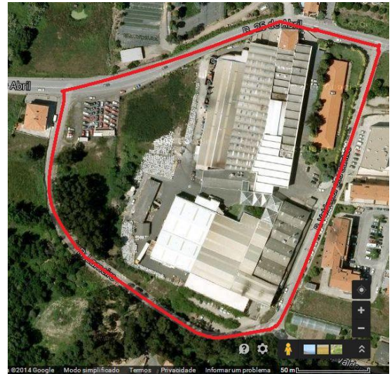
Figura 3 - Vista aérea da ValSan
