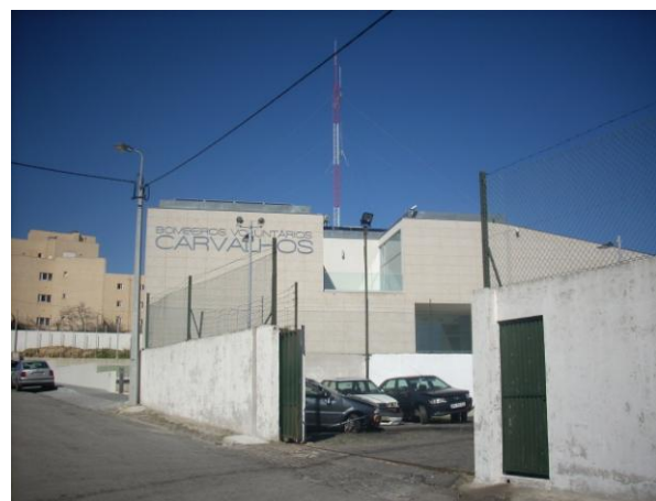
Figura 3- Quartel dos Bombeiros Voluntários de Carvalhos, com aproveitamento de energia solar térmica.
