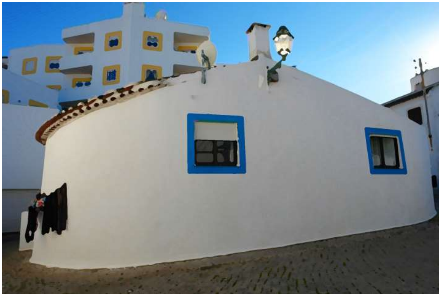
E no meio uma casa como um bolo. Rua da Barreira.
