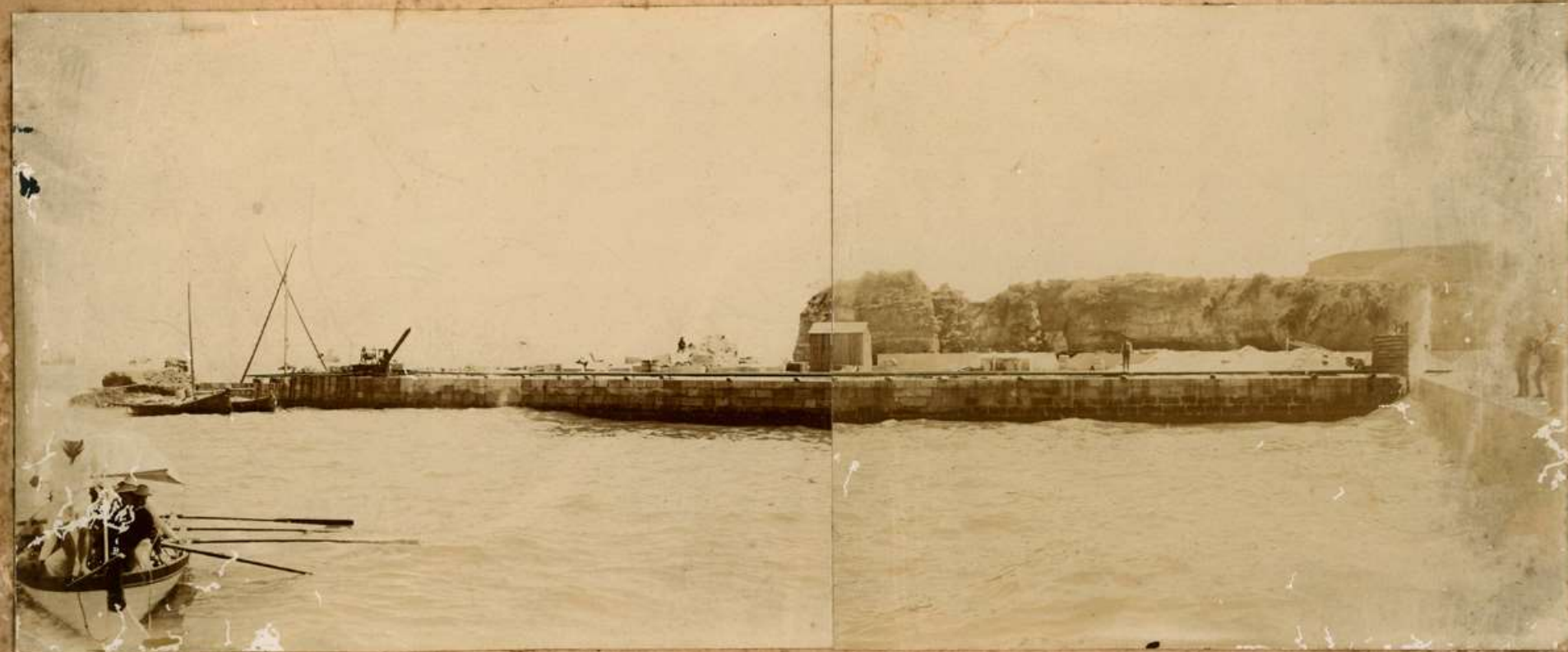
Mofose-caes em construcção na praia da Solaria (Parte construida até a antiga "Pedra amarella") (80,00 m )
