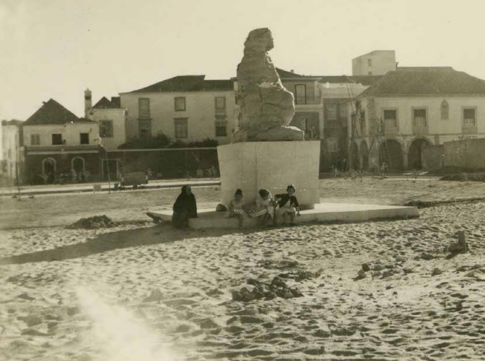
Construção da Praça e colocação da Estátua do Infante (julho de 1960) – foto de coleção particular
