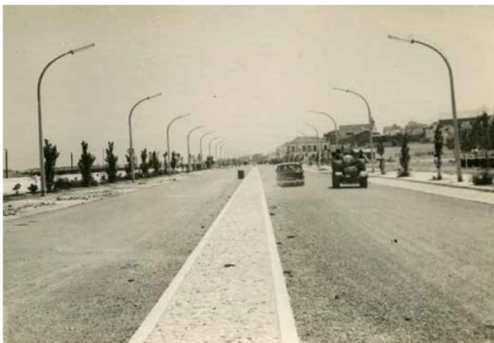
Fase final de construção da Avenida, inaugurada a 7 de agosto de 1960 - foto de coleção particular
