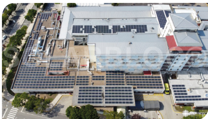
Figuras 5 e 6 Instalação fotovoltaica em cobertura com SOLARBLOC® Coberturas 18° no Hospital Infante D. Pedro em Aveiro. Empresa instaladora: SUNENERGY. Nome da Instalação: Hospital Infante D. Pedro em Aveiro. Potência: 223,2 kWp.
