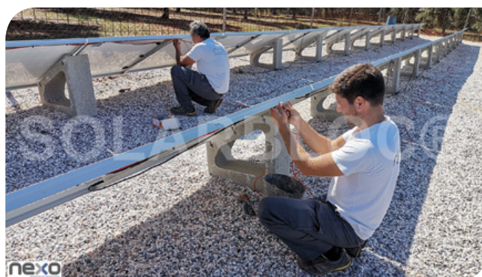
Figuras 7 e 8 Instalações fotovoltaicas em terrenos rurais com estruturas Solarbloc 30°. Empresa instaladora: Nexo Serviços de Engenharia, Lda. Nome da instalação: Moura. Potência: 41,6 kWp.
