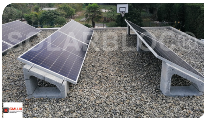
Figuras 2, 3 e 4 Instalação fotovoltaica em cobertura não transitável com acabamento em gravilha com estrutura de cobertura SOLARBLOC® 28°. Empresa instaladora: GMLUX, Lda. Nome da Instalação: Moradia Árvore – Vila do Conde. Potência: 3,95 kWp.
