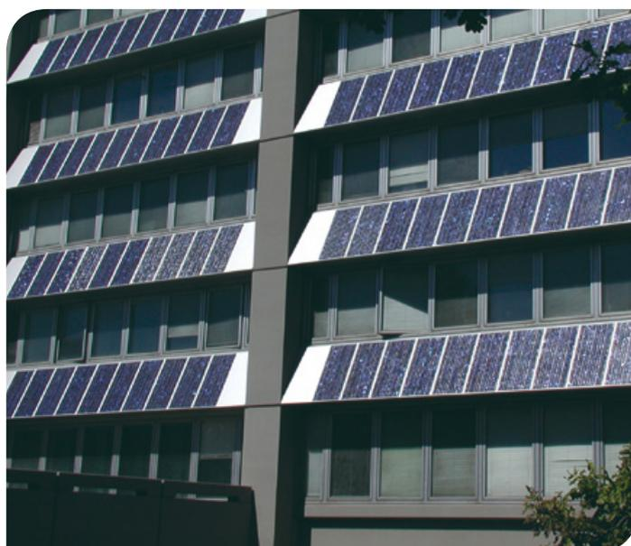
**Figura 3** Sistema fotovoltaico integrado numa fachada de um edifício em Genebra. Fonte: <https://www.flickr.com/photos/us-mission/3881123643>
