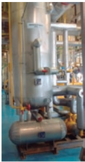
Figura 5. Separador de líquido.
