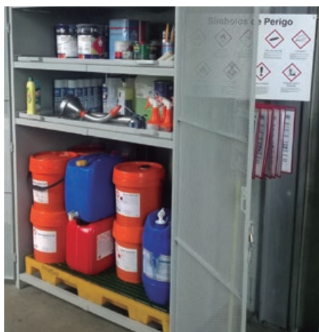
Figura 2. Armário de armazenamento de produtos químicos. Núcleo de Amarante de Cenfim.
