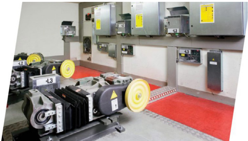
Figura 5. Máquinas gearless , com motores ímãs permanentes, Schindler.
