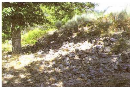
Aspecto do derrube da muralha
