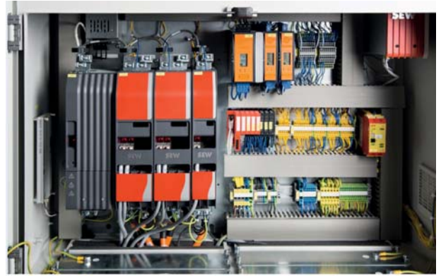
Figura 4. Exemplo de um quadro elétrico limpo depois de feita a manutenção
