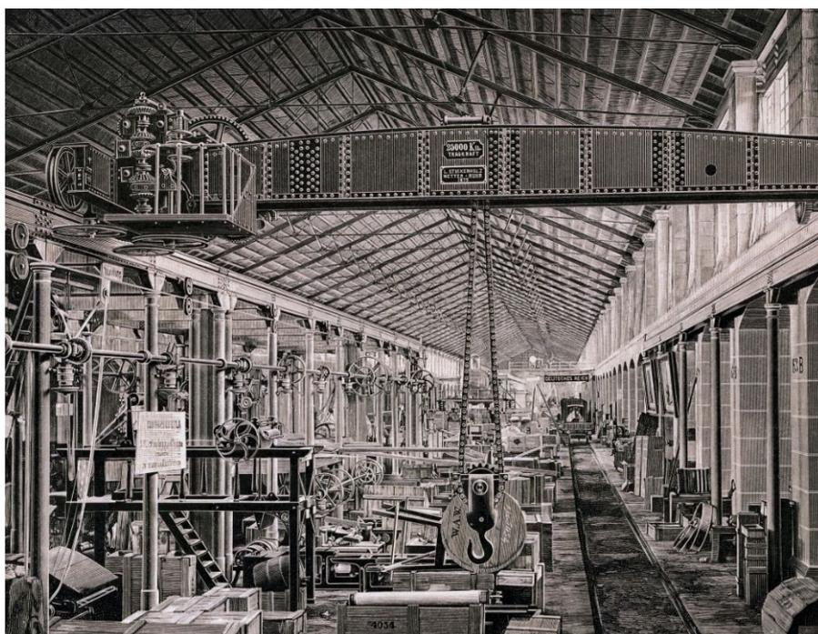
**Figura 1.** Ponte rolante da empresa alemã *Mechanische Werkstätten Harkort & Co.* da qual resultou o fabricante de marca DEMAG.
