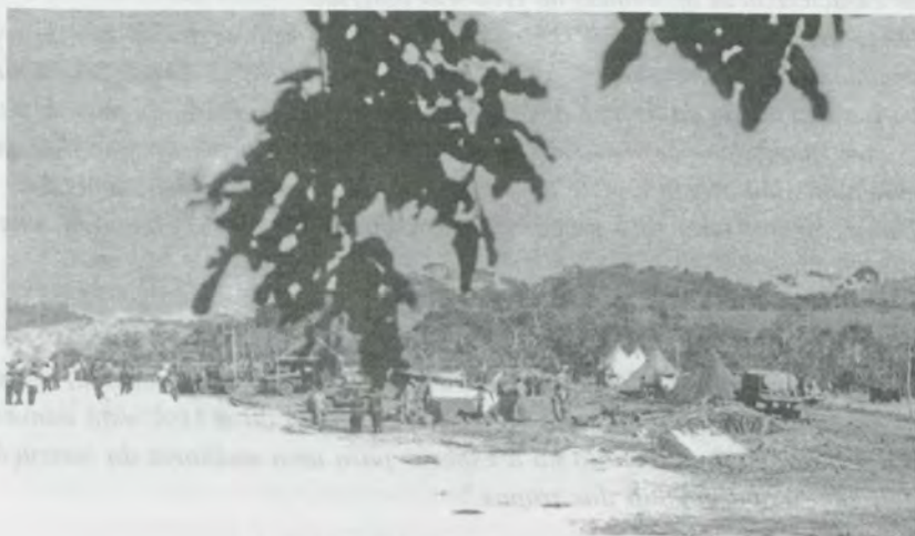
Instalações iniciais no aquartelamento
