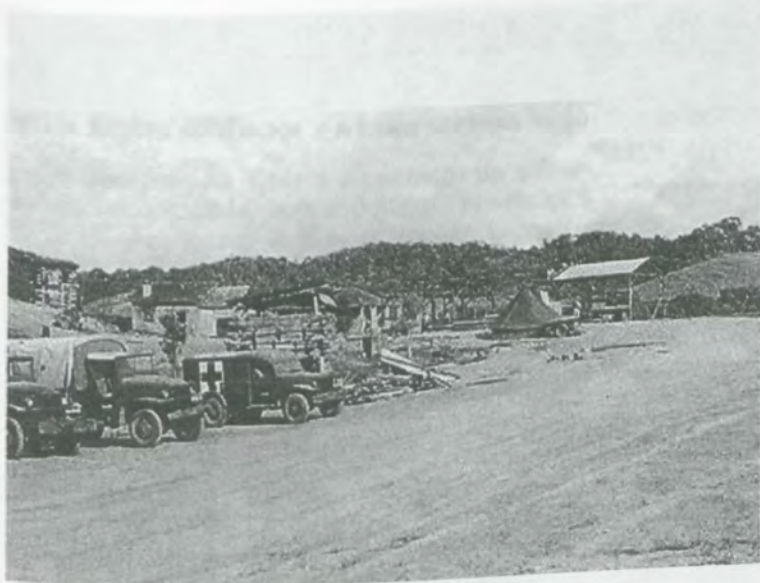
CI-16 na fase de construção
