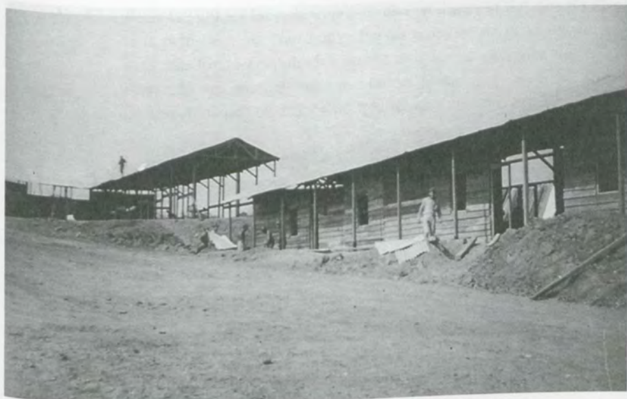
Construção e instalação do Aquartelamento de Zemba (Fotografia retirada da Revista "Mama Sume")
