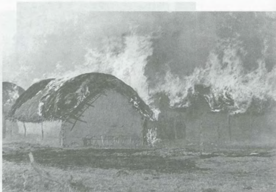
Destruição da tabanca de apoio ao IN em CATUNCO
