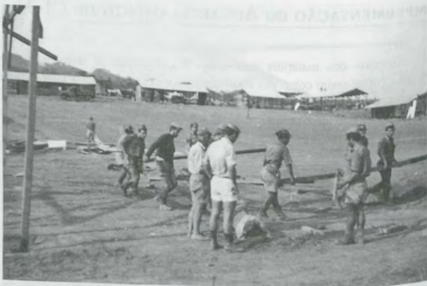
Construção do aquartelamento
