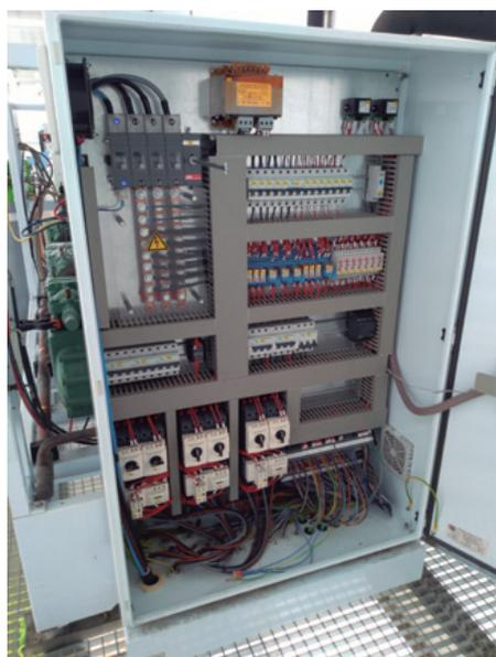
Figura 1. Quadro elétrico de uma central frigorífica com controlador para os compressores e ventiladores.
