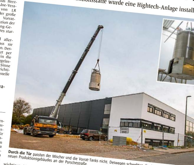
Durch die Tür passten der Mischer und die Vorratt-Tanks nicht. Deswegen schwebten die Anlagen per Kran durch die neuen Produktionsgebäude an der Porschestraße.
