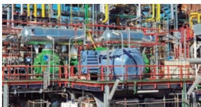
A WEG realizou um importante fornecimento para a Cepsa que inclui um motor à prova de explosão com refrigeração por tubos carcaça 900 K/J, que alimentará um compressor recíproco de uma unidade de recuperação de gás hidrogénio, na refinaria de La Rábida, localizado em Palos de la Frontera (Huelva - Espanha).
