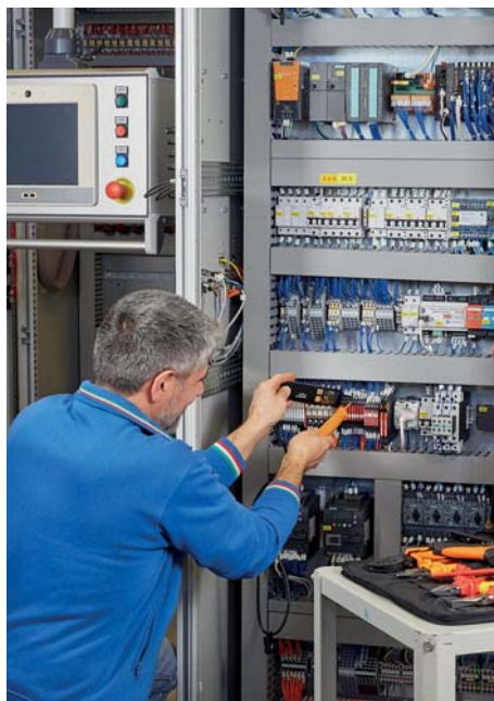
Figura 1. Um cenário típico do trabalho quotidiano de um fabricante de quadros elétricos. (Fonte: Weidmueller Interface GmbH & Co. KG)
