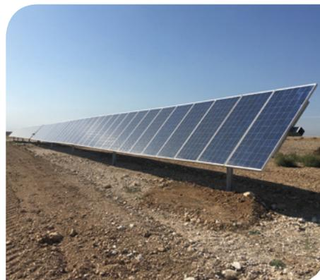
**Figura 2** DEGERtracker S100-PF-SR com 64 painéis de 72 células.
