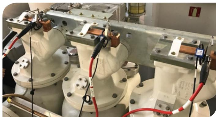
Figura 5 GIS 245 kV com três caixas, uma para cada fase.
