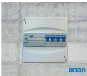
A gama de quadros MINI S da Marca TEV foi desenvolvida de modo a responder aos projetos com custos controlados ou/ com espaço reduzido para instalação.
