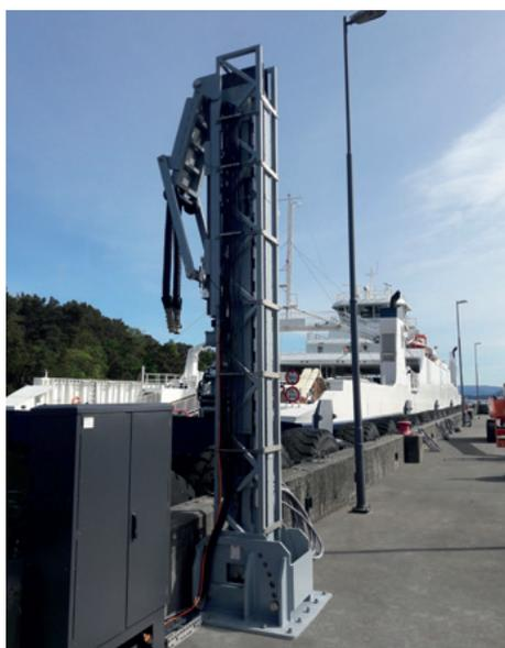
Figura 1. Instalado em pontos de amarração definidos, o dispensador com calha articulada permite o fornecimento seguro de energia aos navios a partir de um terminal portuário, graças a uma calha articulada extensível e cabos chainflex altamente flexíveis (Fonte: igus GmbH).
