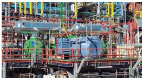
A WEG realizou um importante fornecimento para a Cepsa que inclui um motor à prova de explosão com refrigeração por tubos carga 900 K/J, que alimentará um compressor recíproco de uma unidade de recuperação de gás hidrogénio, na refinaria de La Rábida, localizado em Palos de la Frontera (Huelva - Espanha).
