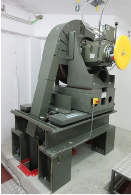
Figura 6. Máquina do novo elevador, Schindler.
