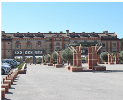
Figura 3. Edifício do Acolhimento.
