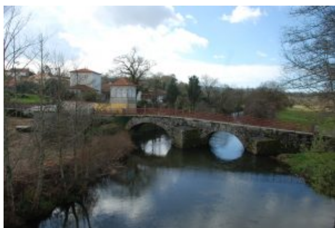
6 – Ponte de Fragoso
