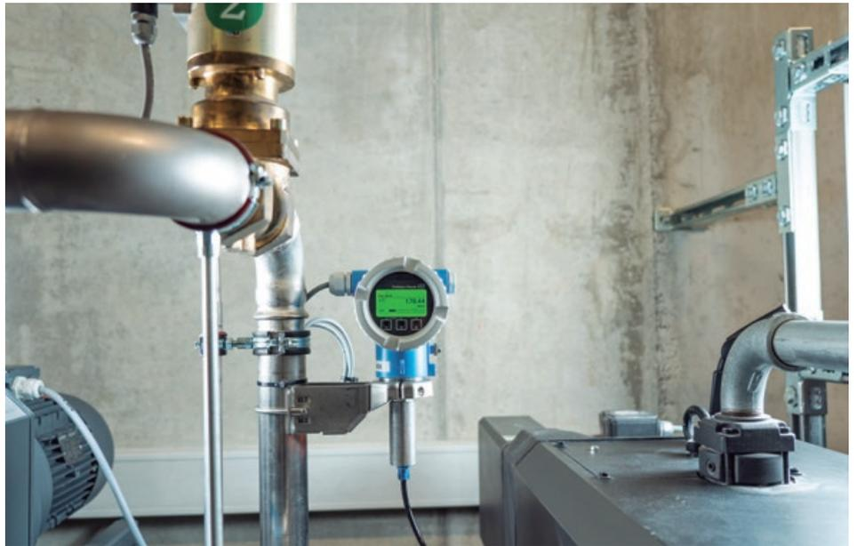
muda de verde para vermelho. A mudança de cor permite que o operador perceba imediatamente o mau funcionamento, sem ter que abrir a estrutura de menu de um dispositivo.
