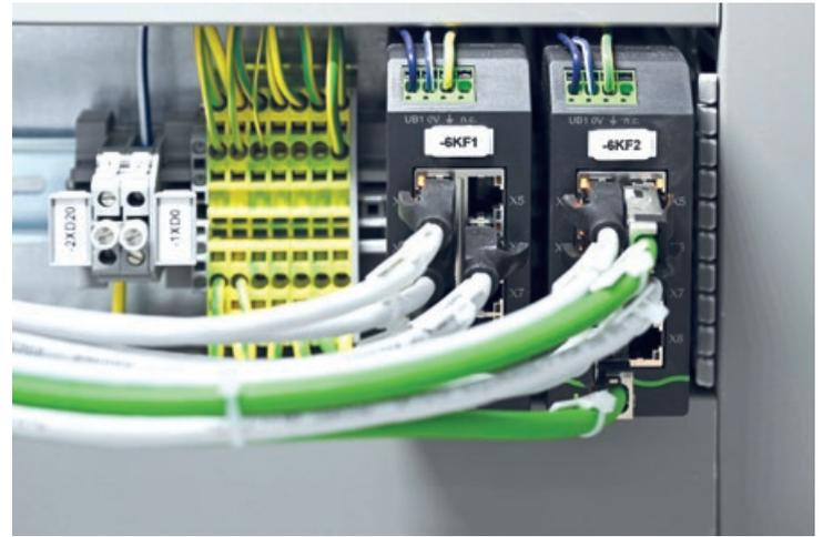
sem gestão Tree16 TX da Murrelektronik. Este switch de 16 portas sem gestão tem 2 portas Gigabit Ethernet uplink e 14 portas Fast Ethernet downlink.
