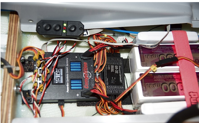
Foto 1: as baterias LiPo de alimentação do r/c estão colocadas no lado exterior das baterias de propulsão, com o receptor duplo pelo meio.
